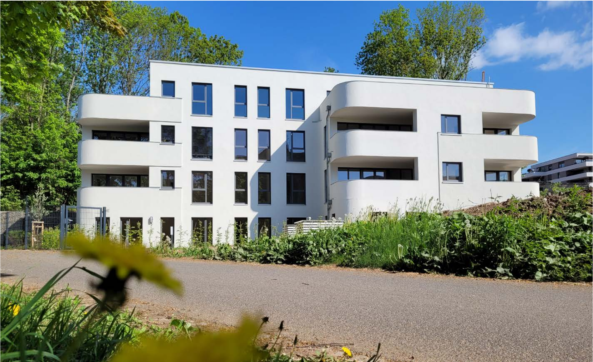
Referenzobjekt HANSA Real Estate Ulmenstraße 5 Neubau, Chemnitz
